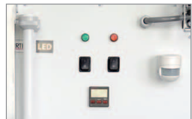
Bedienfeld auf Leuchtenseite A mit Notaus-Sensor
